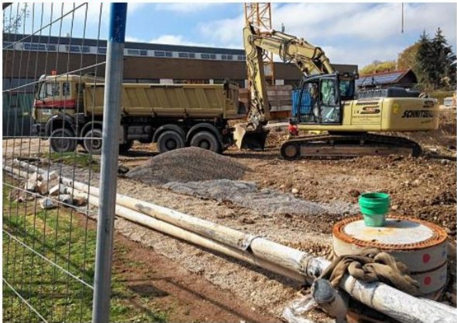
Zweigeschossig wird der Anbau für rund 8,5 Millionen Euro. Er bietet unter anderem Platz für zahlreiche Fachräume, Technik, Ganztagsbereich und Büros. FOTOS MISCHI
