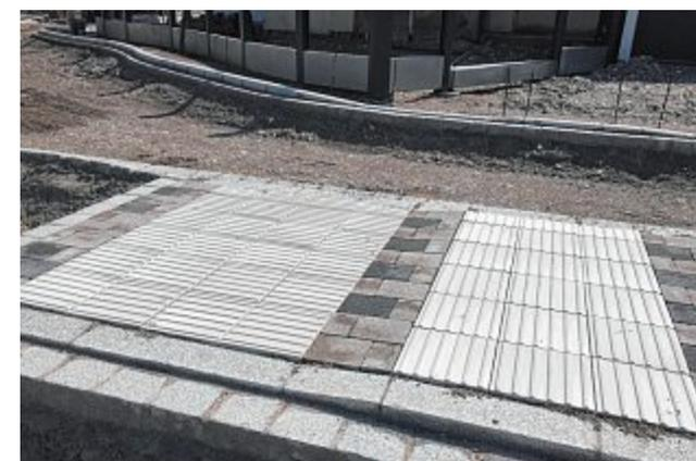
Die Querungshilfen: für Sehbehinderte ist der rechte Übergang. Diese Kante ist erforderlich. Im linken Bereich wird diese noch abgefräst.
