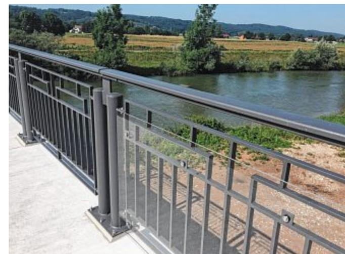
Eine der Spritzschutzwände für Radfahrer, die unter der Mangfallbrücke auf dem Dammweg unterwegs sind.
